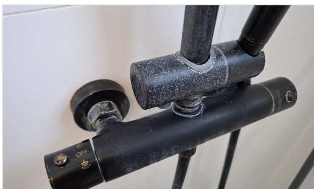
G Douchekraan/regendouche: volledig vervangen door de reeds door de klant bestelde nieuwe set.
