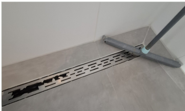
F Douchegoot/rooster: vervangen door het reeds door de klant bestelde nieuwe onderdeel.
