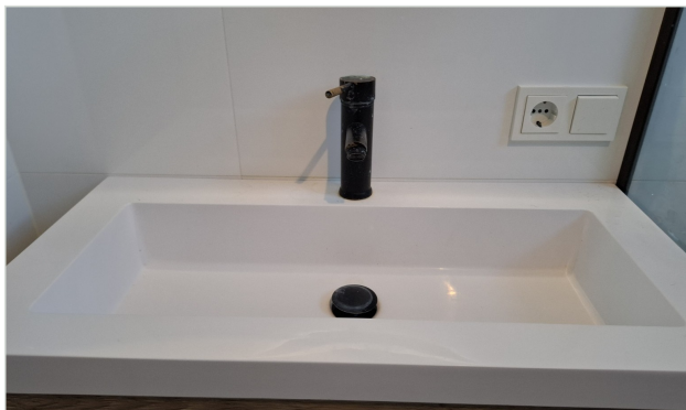
E Wastafelkraan: vervangen door het reeds door de klant bestelde nieuwe exemplaar.
